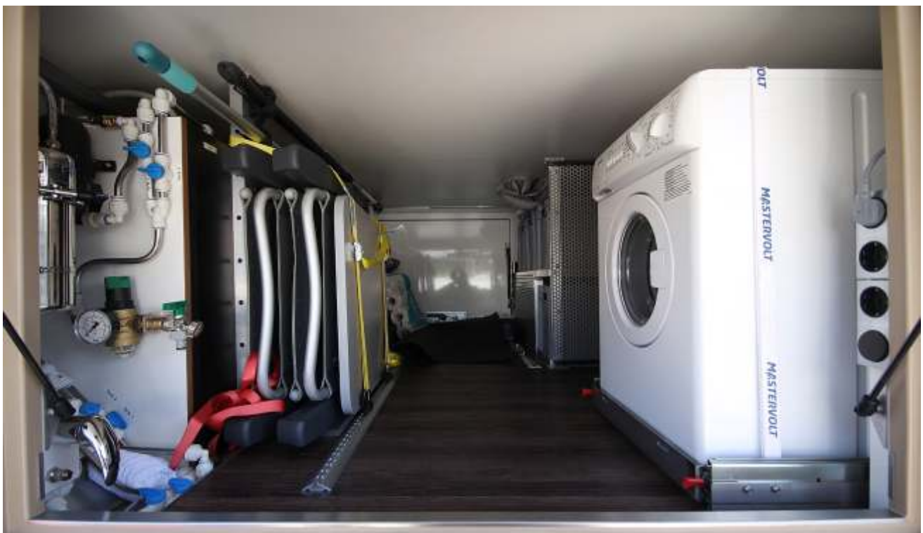
Die Technische Installation und die Waschmaschine sind in der sehr geräumigen Heckgarage untergebracht in der dennoch sehr viel Stauraum zur Verfügung steht. Dieser Stauraum ist von beiden Fahrzeugseiten und von der Wohnkabine zugänglich.
